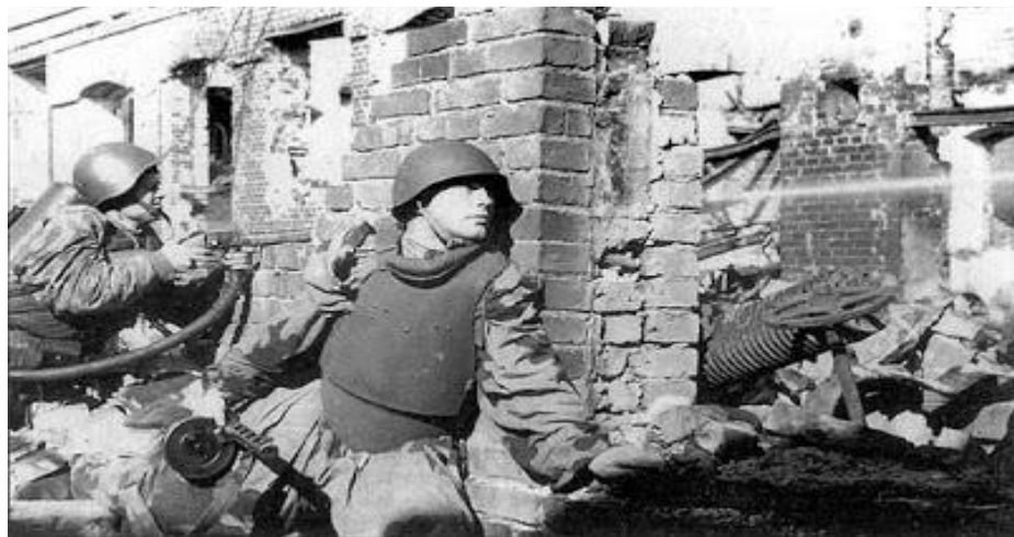
Figura 18: Destruição na Praça Vermelha (URSS). Fonte: Internet 53
